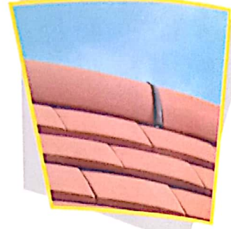
سقف القرمید ٹائلوں سے بنی چھت "Tiled Roof"
