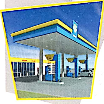
مَحْطَةُ الْوَقُودِ پٹرول پمپ Petrol Station
